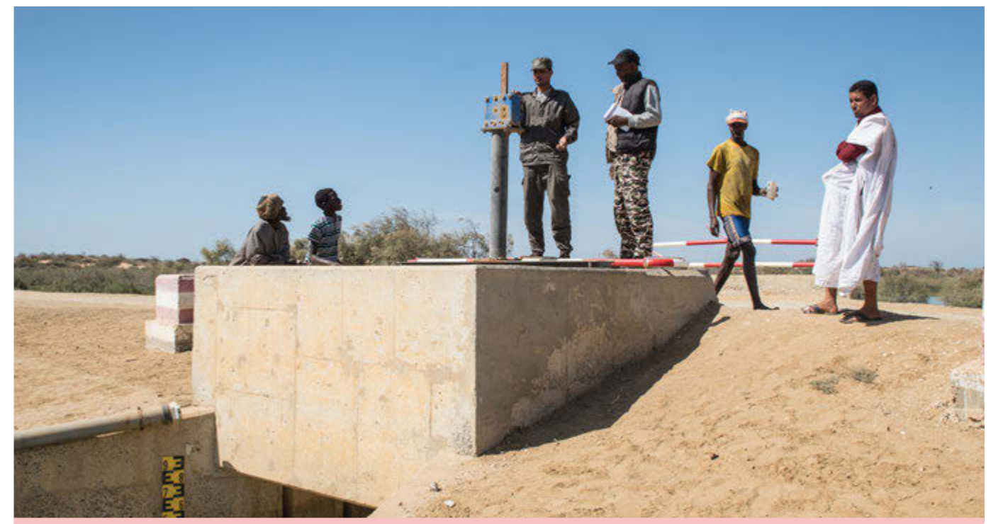
Ouverture de vanne, ouvrage de Bell, PND
